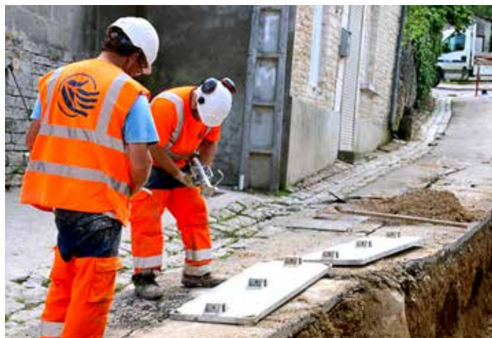
Les équipes du SDDEA (303 agents) exploitent les installations de production, réparent les réseaux, effectuent des contrôles, afin de garantir un accès en continu à une eau de qualité.
