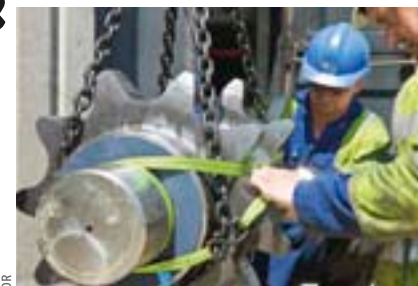
Mise en place d'un pignon de chaîne Sedis sur un barrage.
